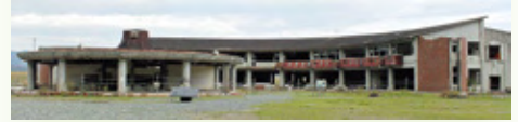
津波は鉄筋コンクリートの壁を突き破りすべてを飲み込んだ
